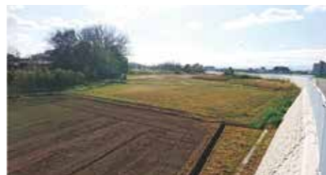
川越江川下流域の川崎地内
