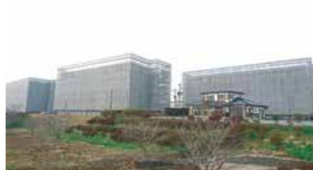
完成間近の災害公営住宅
